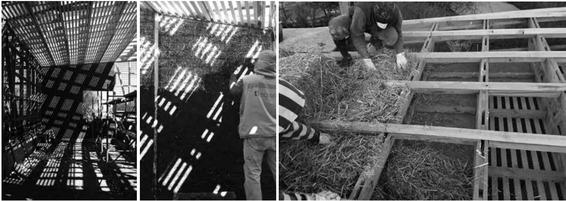
FIGURA 3. DE IZQ. A DCHA.: MURO DE QUINCHA EN CASA ABALOS; MURO DE QUINCHA SECA EN CASA ABALOS; SISTEMA DE CUBIERTA EN CASA ABALOS. FUENTE: FOTOGRAFÍAS DE LA AUTORA DEL ARTÍCULO.
