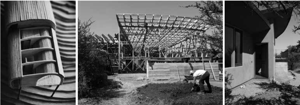
FIGURA 2. DE IZQ. A DCHA.: MAQUETA DEL HOTEL DE TIERRA LOS RUCOS; ESTRUCTURA DE LA CASA ABALOS; CASA ABALOS CON REVESTIMIENTOS DE TIERRA. FUENTE: FOTOGRAFÍAS DE LA AUTORA DEL ARTÍCULO.
