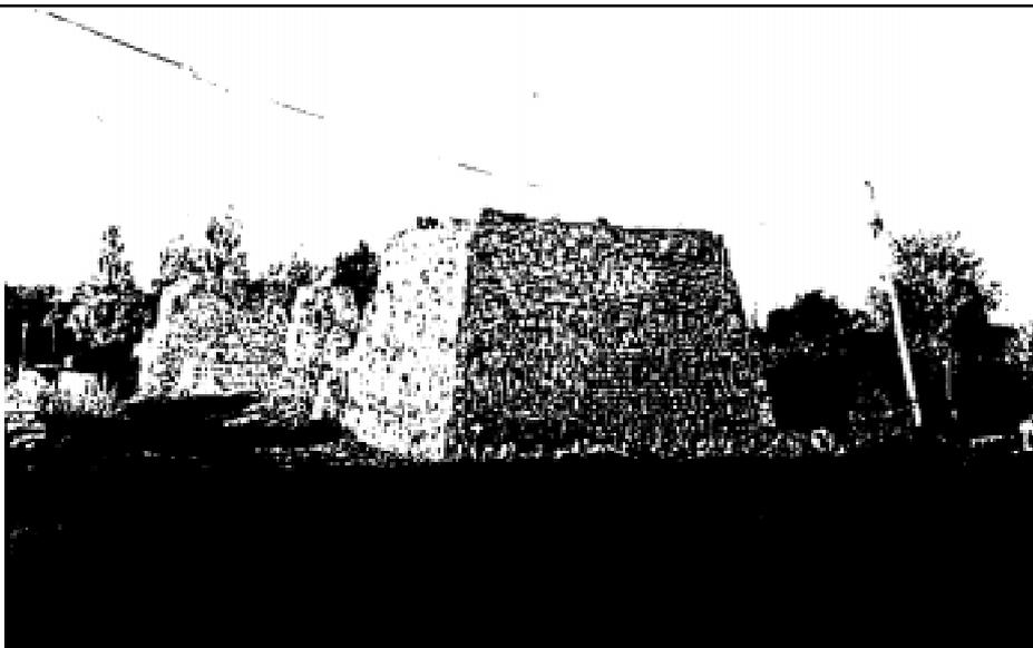
**Figura N° 22.** Horno de ladrillos de campo tipo hormiguero
