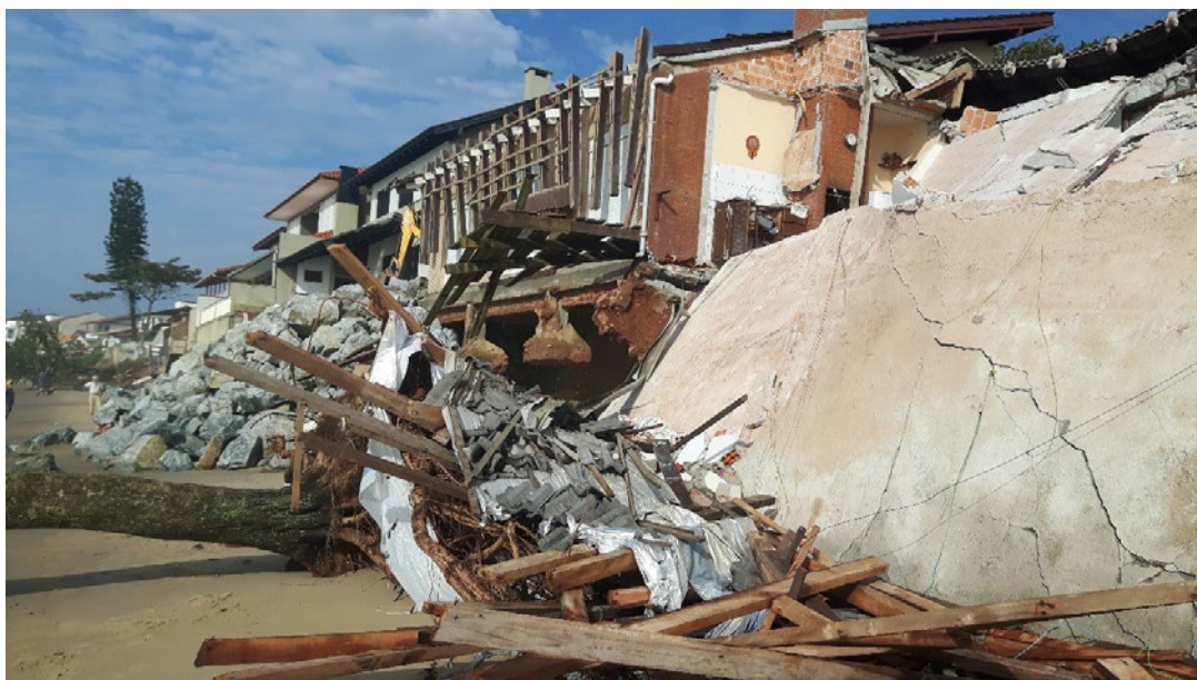
Figura 5. Obra de enrocamento na praia das Pedras Brancas e Negras. Fonte: Autores (2017).
