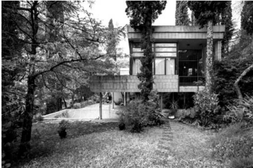
Casa Perossio. Arenitas Blancas Arq. Carlos Rodríguez Fosalba Fotografía: NACHO CORREA, SMA
