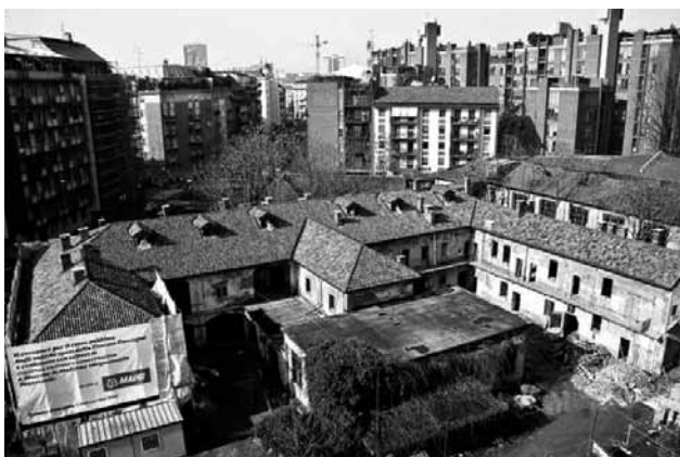
Casona abandonada. Hacia fines de la década de los noventa se formó una cooperativa y más tarde un consorcio de cooperativas, al cual se le adjudicó una concesión por veinte años que permitió proceder a la recuperación edilicia y transformar la antigua estructura en un centro polifuncional de iniciativa y participación cultural territorial. Fotografía: proyecto Cascina Cuccagna.
